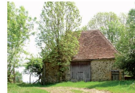
**Dans la vallée de l'Auvézère**, au contact de la Dordogne et de la Haute-Vienne, les granges “limousines” se généralisent, avec de hautes toitures à croupes couvertes de tuiles. Les encadrements de baies en bois consolident des maçonneries précaires en pierre “tout-venant”.
