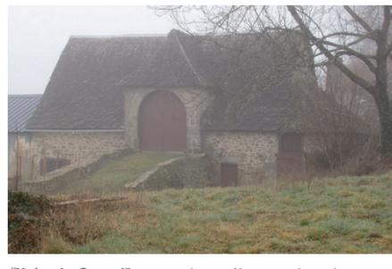
**“Xaintrie-Cantal”** porte charretière sur le même mur gouttereau que la porte d'étable avec rampe d'accès. Porte charretière encadrée de contreforts et/ou surmontée d'un toit indépendant, dont le comble sert de pigeonnier à l'aspect d'un porche ou d'une tour ; une 2<sup>ème</sup> porte d'étable en pignon.
